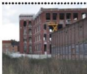
Anciens bâtiments industriels reconvertis en loft
