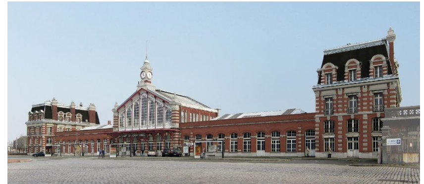
Rénovation du bâtiment Voyageurs par Gares & Connexions
