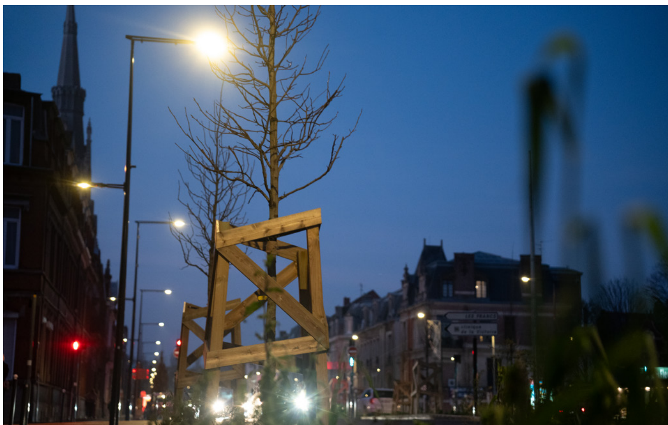
Passage de l'éclairage en LED du boulevard Gambetta
