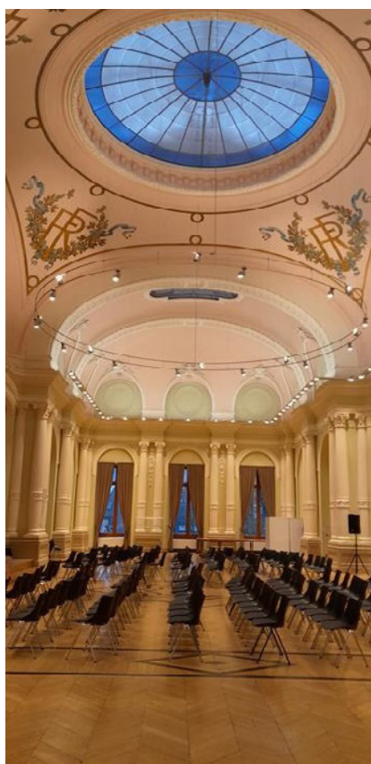
Remplacement de l'éclairage de la salle des fêtes de l'Hôtel de Ville
