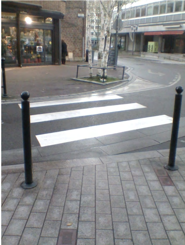
Traçages de passages pour piétons rues de la Cloche et Nationale
