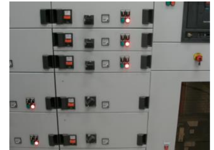
Phase 4 Equipements Automatismes
