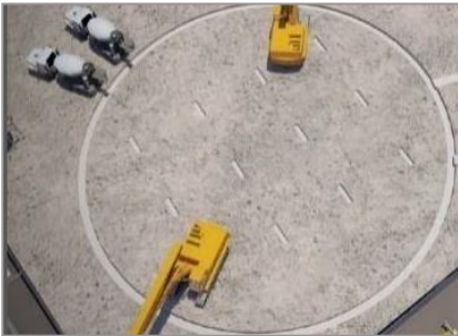
Phase 1 Parois Moulées
