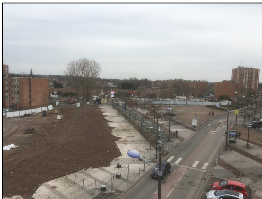
Chantier de démolition des bâtiments 5 (LMH) et Perrault 2 (Vilogia)
