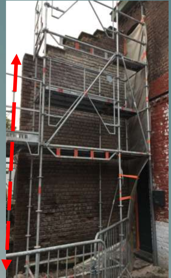
Travaux en cours
