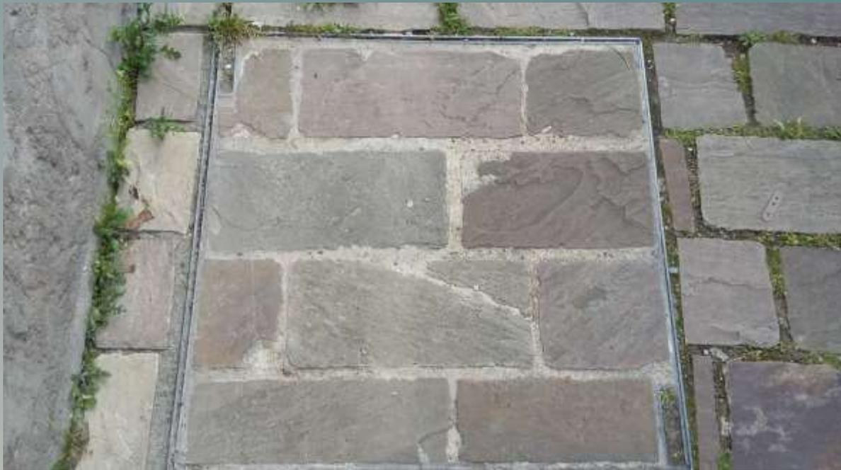
Actuellement, les tampons de regard d'assainissement sont difficiles d'accès en cas de besoin d'ouverture. De plus, herbes et mousses se sont invitées dans les jointures.
