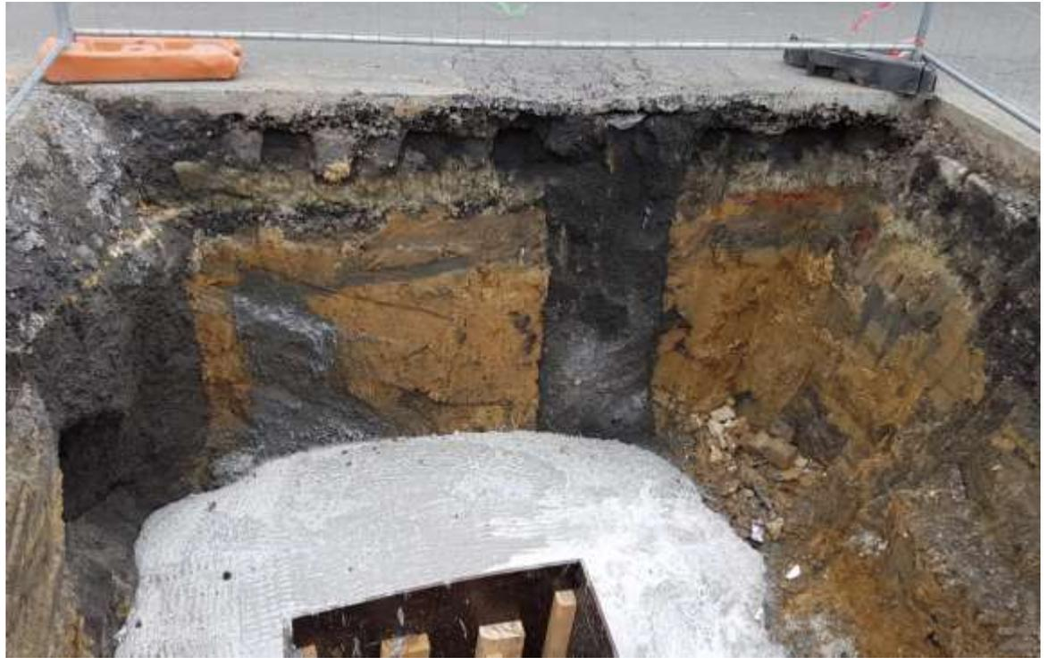
Le fond de forme de la chaussée – on remarque une structure en pavés
