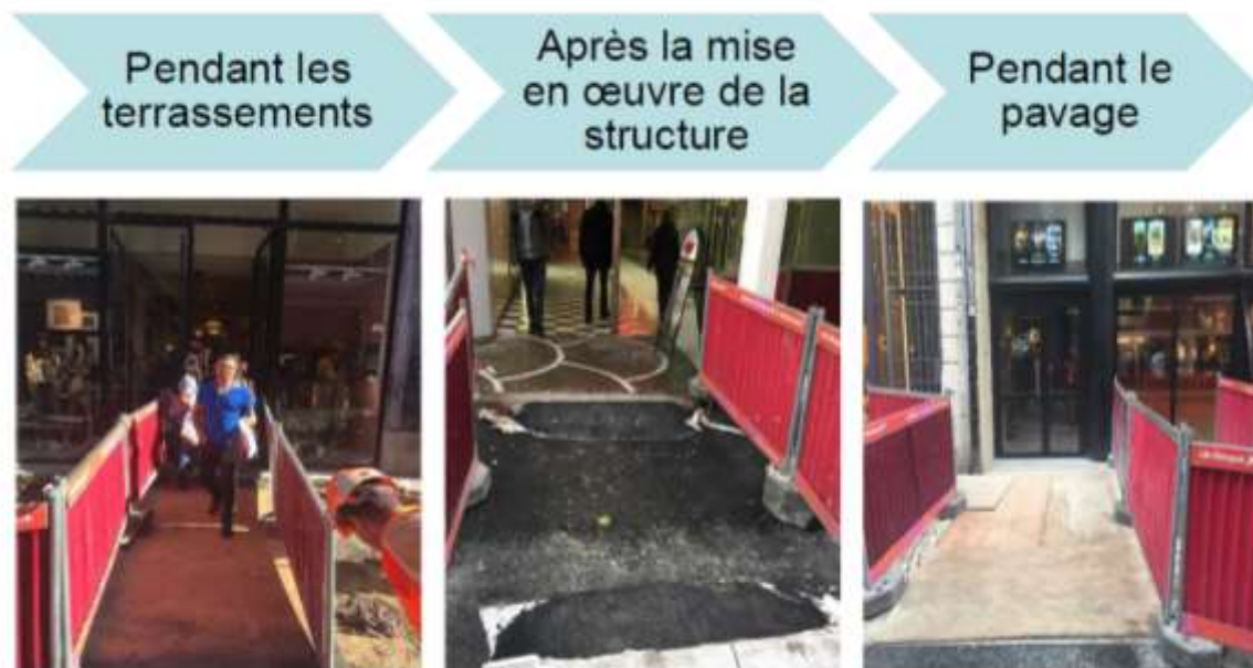
Photos prises lors de travaux rue de Béthune à Lille
