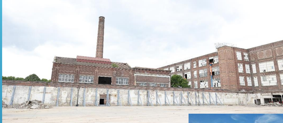
Site Lepoutre-La Redoute
