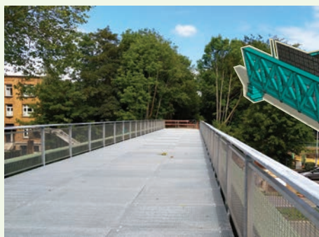
Photo et schéma de rénovation de passerelle
