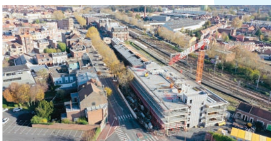
DR. Construction du parking silo, avenue Alfred Lefrançois
