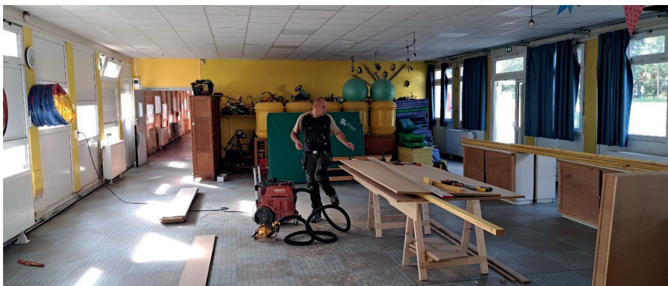
Travaux dans l'école Branly
